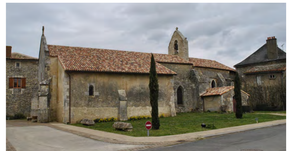
Photographie 56 : Eglise Saint-Martin (MH n°3).
