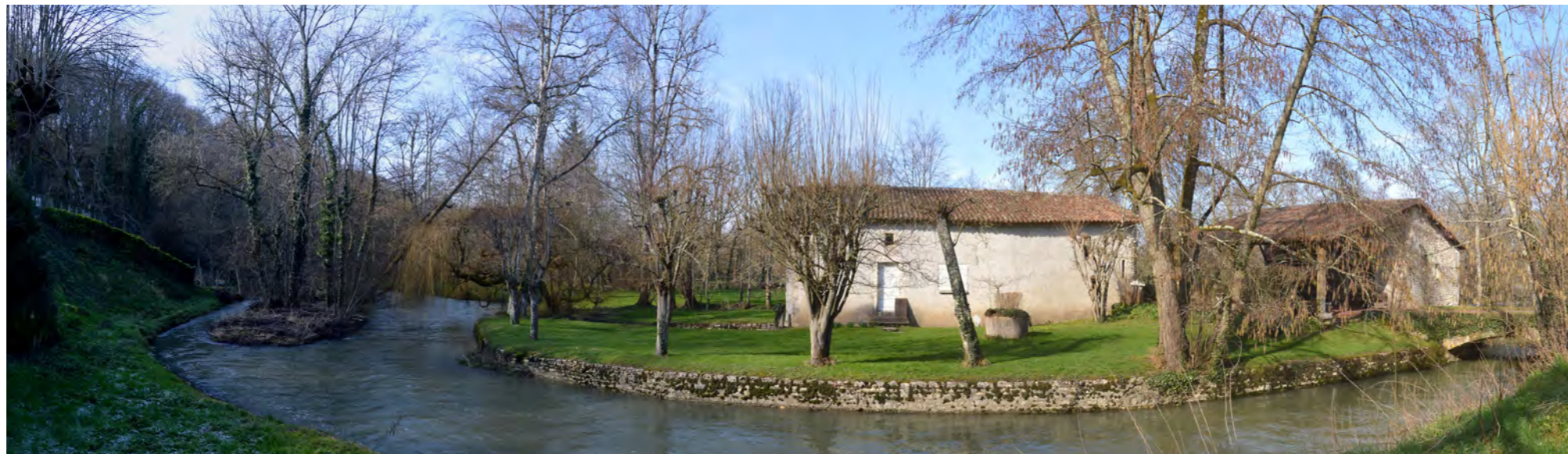
Photographie 69 : Le moulin des Âges.
