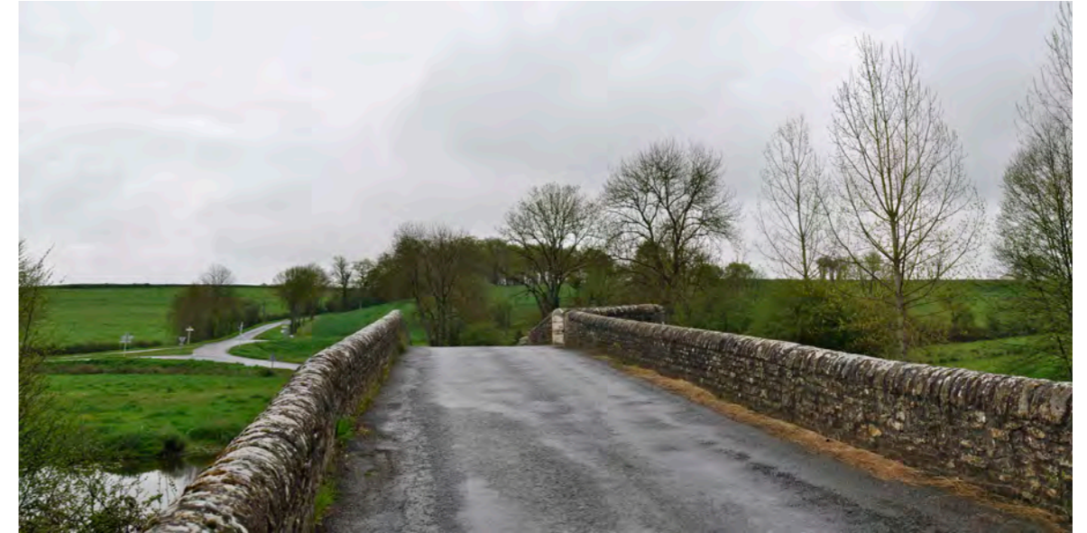
Photographie 49 : Pont sur la Charente (MH°31) à Chatain.
