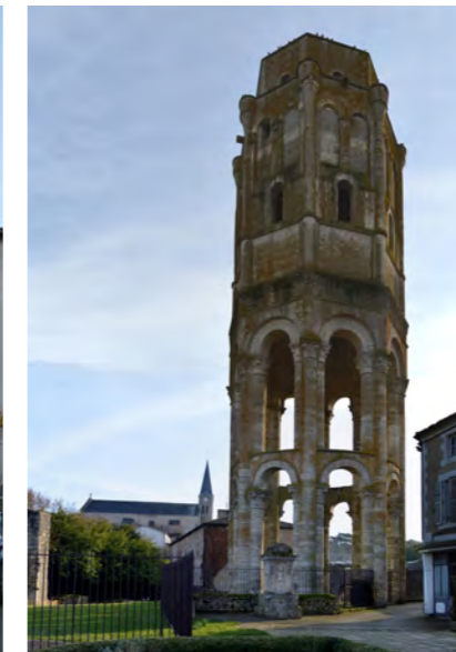
Photographie 65 : Tour lanterne de l'abbaye St-Sauveur.
