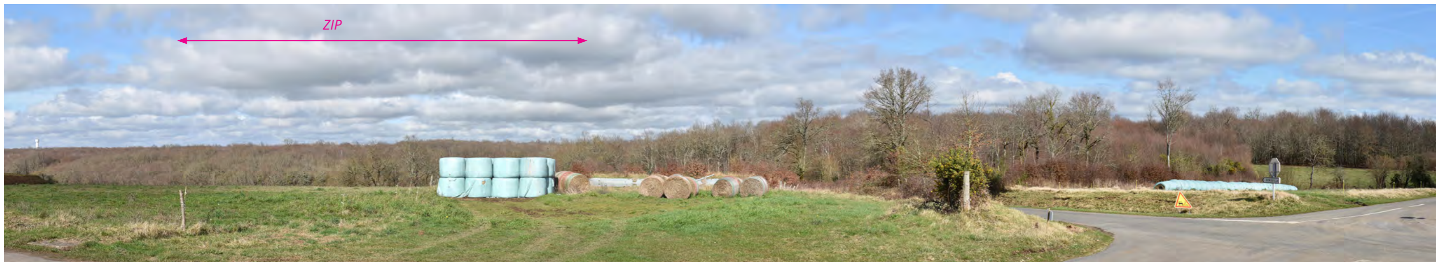
Photographie 118 : Depuis la D36, vue large sur la ZIP.
